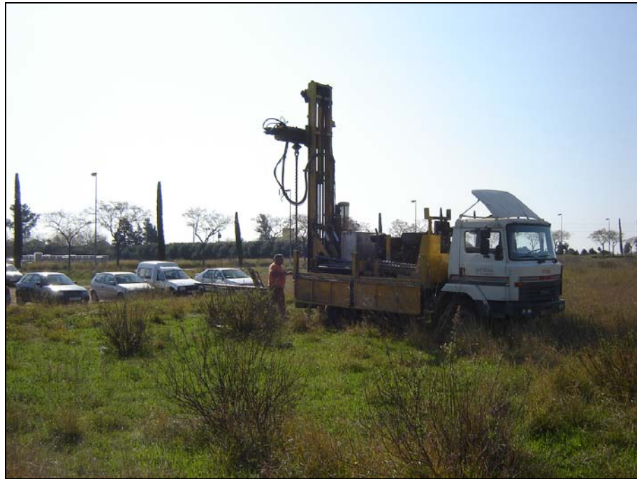
Foto 1: Màquina de sondejos treballant.
