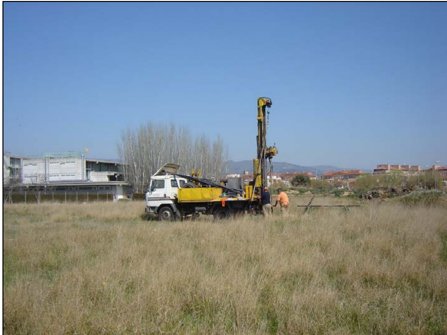
Foto 3: Màquina de sondeig emplaçada.
